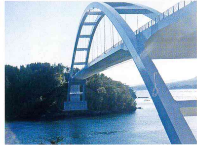
大島大橋「鶴亀大橋」
